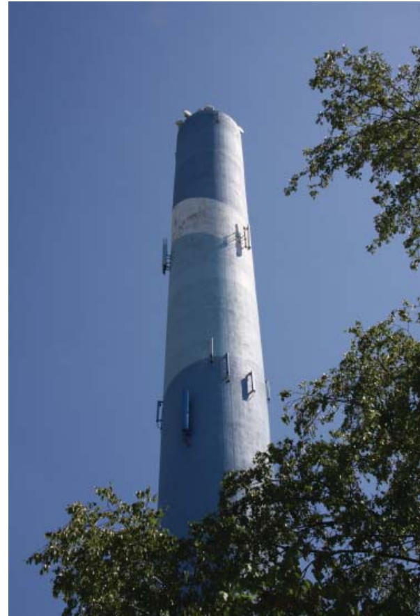
Antenner fra flere operatører, placeret på eksisterende bygningsværk i Herning.
