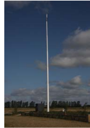
Rørmast med én udbyder
