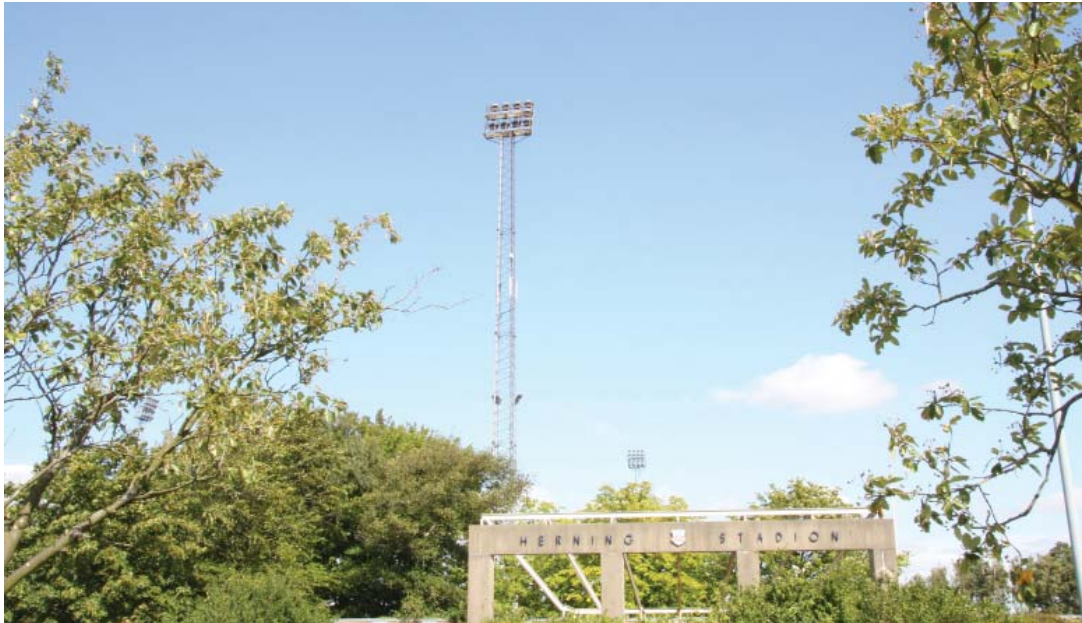
Antennet placeret på lysmast ved idrætsanlæg
