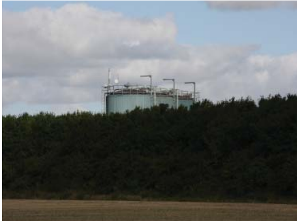
Antenner placeret på biogas-anlæg nær Sinding
