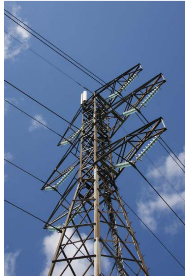
Antenne placeret på eksisterende højspændingsmast (Genvejen i Århus).
